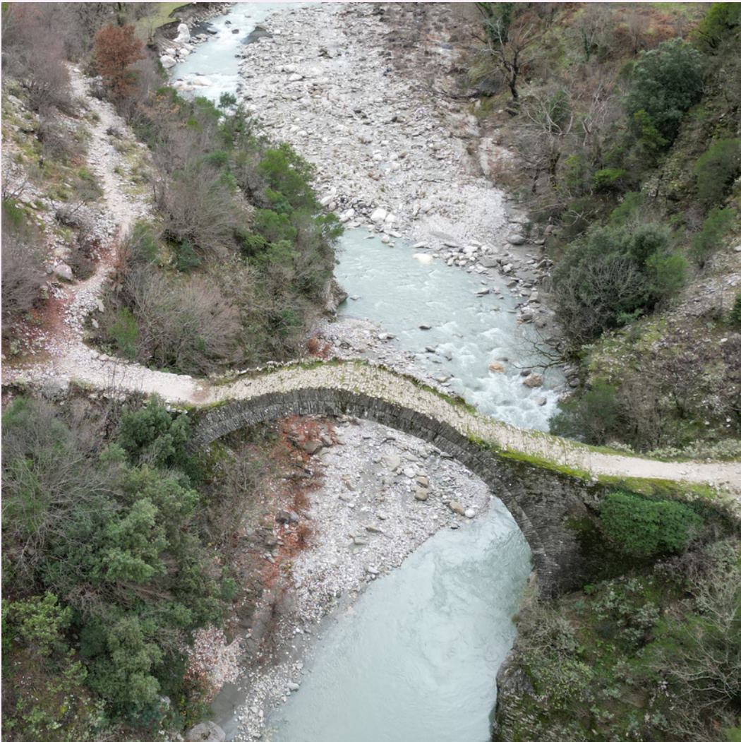
Il ponte Kadiut a Permet, in Albania, sul fiume Lengarica
