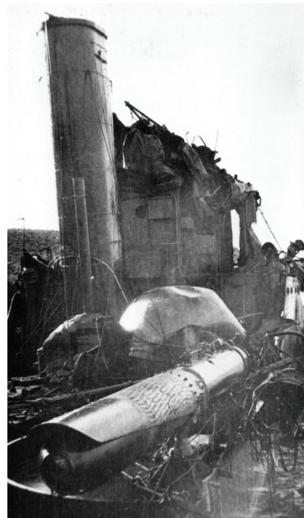
Figura 17: La zona di centronave dell'*Intrepido* con il tubo lanciasiluri di dritta con all'interno l'arma e il fumaiolo prodiero mentre erano in corso le operazioni per rimuovere dal cacciatorpediniere irrimediabilmente danneggiato i materiali e le attrezzature che potevano essere reimpiegati (Collezione Luigi Accorsi tramite Associazione Venus)
