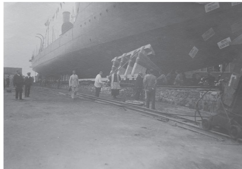
Figura 9: L'*Intrepido* sullo scalo di costruzione delle Officine e Cantieri Napoletani Pattison pronto per il varo il 7 agosto 1912. Si può notare la forma particolarmente slanciata dello scafo, adatto per navigare ad alta velocità (Fototeca dell'Ufficio Storico della Marina Militare)
