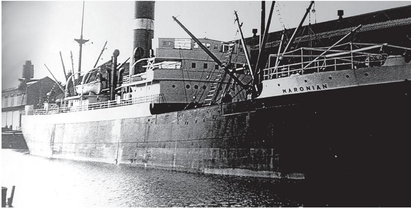
Figura 56: Un'altra foto del *Maronian* nella quale si può notare la parte frontale della plancia e il picco di carico prodiero (Collezione Flavio Serafini)
